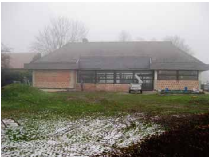
Die Ummauerung wurde entfernt
