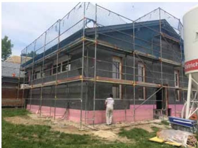
Die thermische Isolierung hält uns schön warm
